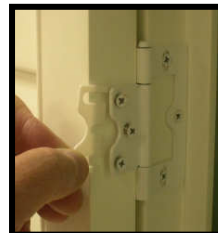
Insert hinge spacer
